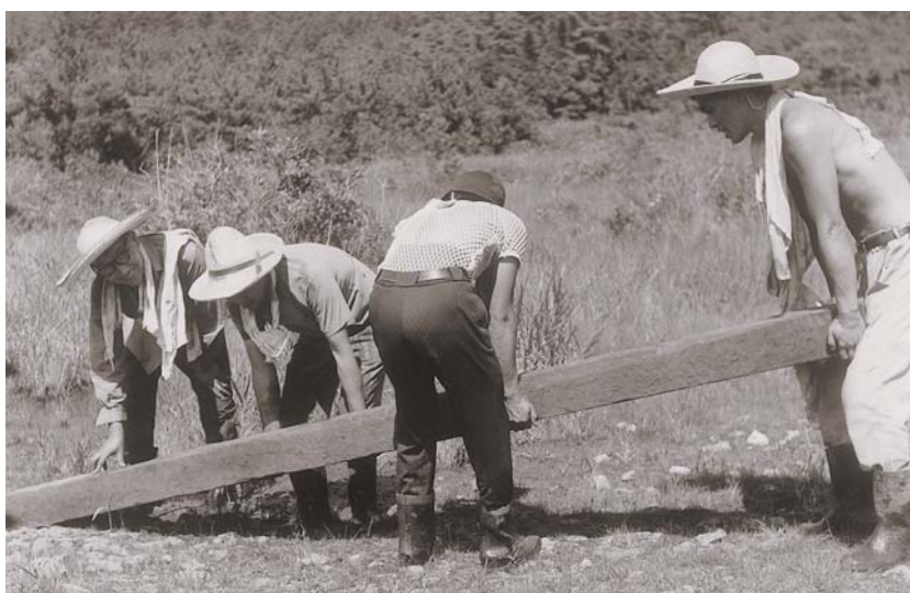
1967年 炎天下の遊歩道設置作業
